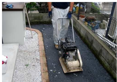
十分な厚さの路盤材としかりとした転圧は舗装工事に欠かせない。
