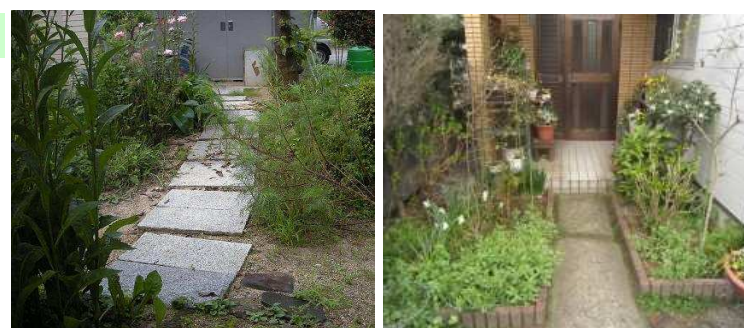
敷石のピッチが歩幅と合っていない。据付も不揃い。庭木も通行の邪魔。 通路幅が狭くお孫さんのベビーカーが通りづらい。段差もある。
