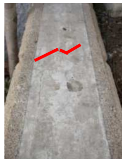
よく見ると細かいひびが→
